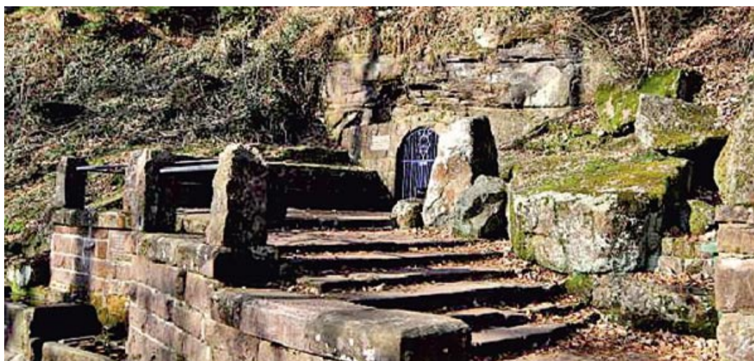
Abb. 3: Der ausgebauter Zugang zur Quelle mit Becken*
