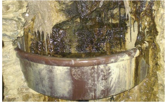
Abb. 9: Sammeln des austretenden Wassers im Bergstollen
